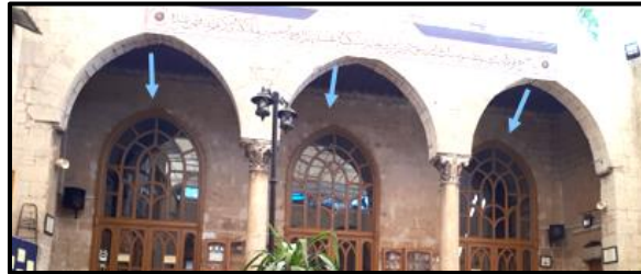
الصورة (5): العقود المدببة فوق أبواب الدخول في الواجهة الجنوبية القبليّة 4
