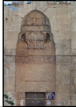
الصورة (15): نصف قبة (عقد نصف دائري) لمدخل مدرسة الفردوس 3
